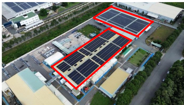
赤枠内：パネルの敷設箇所
