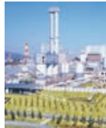
（神戸製鋼所 石炭火力発電所）
