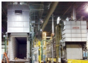
焼鈍炉（据付中）
